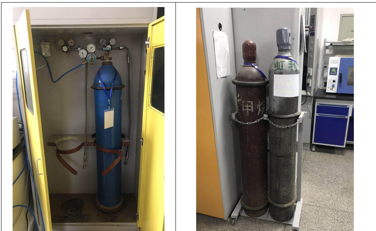
图 3. 格致楼 2043-1, 已整改。氧气瓶和甲烷已分开存放, 甲烷气体存放在 2053 实验室。
